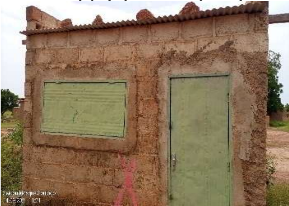
Photo 5 : Maison en parpaing impactée dans le Village de Soulgo, Commune de Ziniaré
