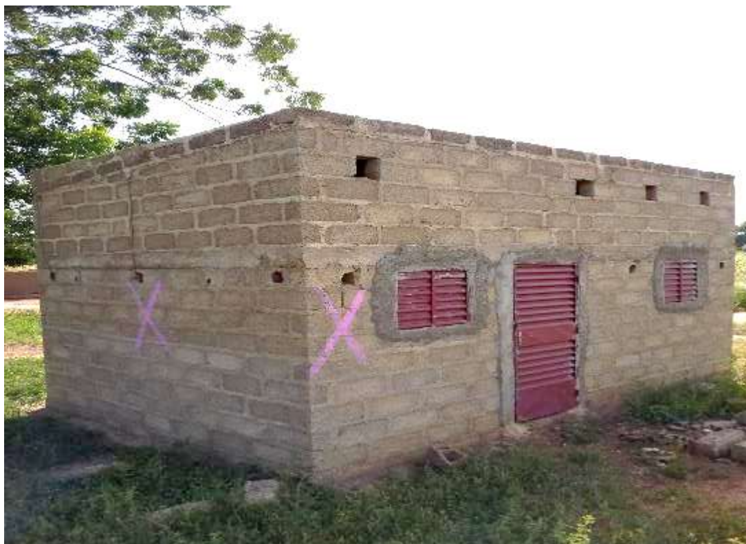
Photo 2 : Maison en parpaing impactée dans le Village Bangrin, Commune de Ziniaré
