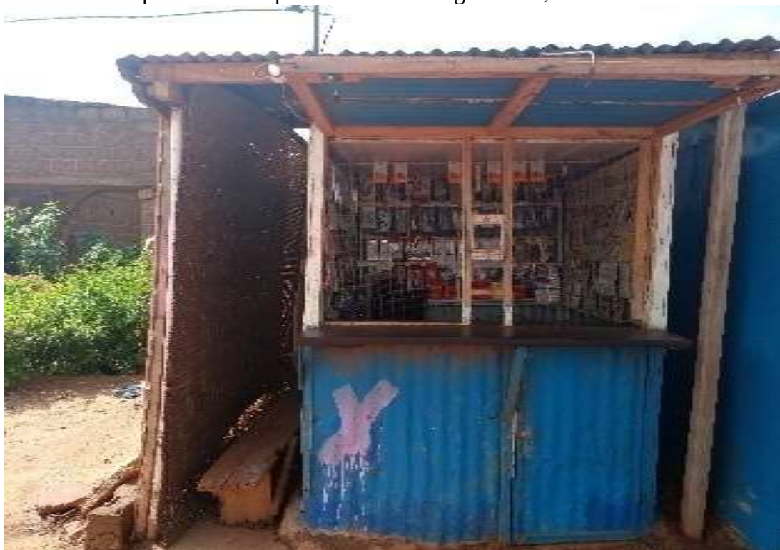
Photo 1 : Kiosque en tôles impactée dans le Village Kouila, Commune de Ziniaré
